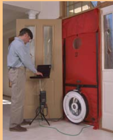
Blower door test
